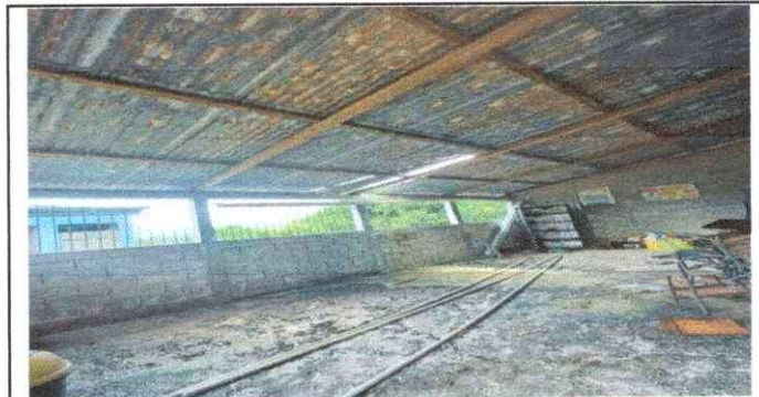
Foto 6: Se observa el deterioro de la estructura metalica del entechado.
