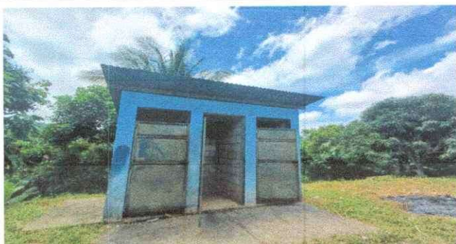
Foto 5: Se observa el deterioro del entechahdo y puertas del baño.
